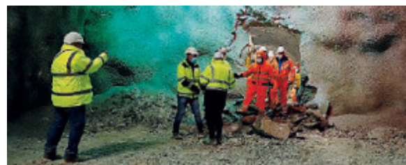
Le fasi dei lavori. /FABIO CATALDI
