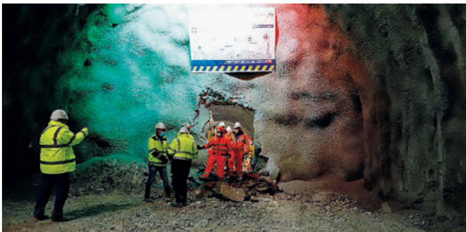
L'abbattimento del diaframma. /FOTO INFRA.TO.
